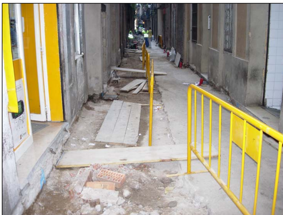
Foto 8: Vista des del nord est del carrer Serra després de l'extracció de les llambordes
