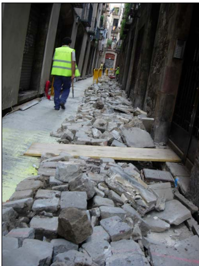
Foto 7: Vista des del sud-est del carrer Serra durant el procés d'aixecament de les llambordes
